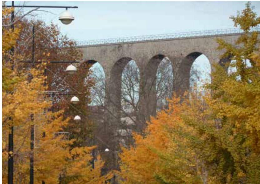
**L'aqueduc d'Arcueil-Cachan.** Pour améliorer l'alimentation en eau potable des Parisiens, Eugène Belgrand propose, en 1866, la construction d'un aqueduc de dérivation de la Vanne qui se superpose à l'aqueduc Médicis. Les eaux de la Vanne se déversent dans le réservoir de Montsouris, d'où elles sont envoyées jusque dans les immeubles parisiens. Le pont-aqueduc d'Arcueil-Cachan fait désormais partie intégrante du paysage urbain.
