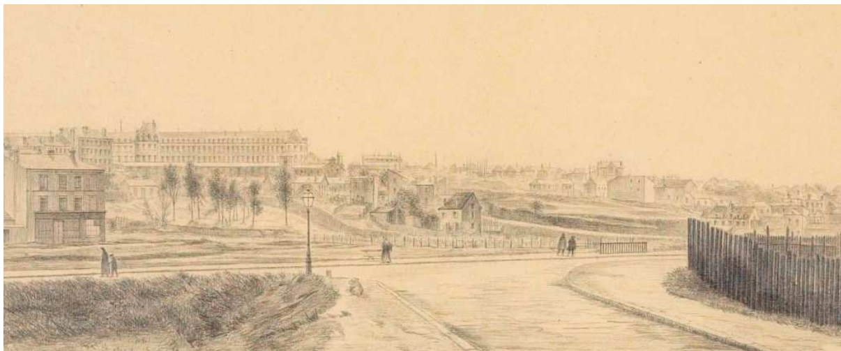
Image 5 : Le Kremlin-Bicêtre en 1898 – Emplacement actuel de la place de la mairie – Archives de Paris
