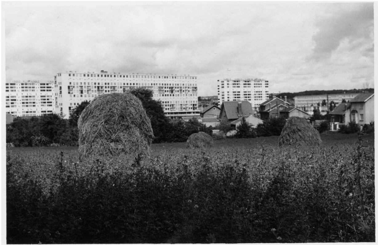
Image 3 – La construction du Clos en 1960 – Centre de ressources de l'écomusée du Val de Bièvre
