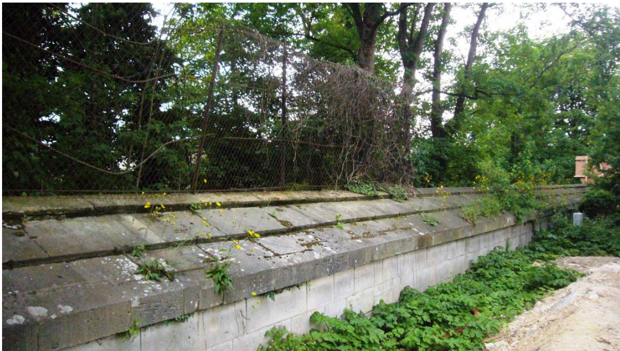
Image 2 - Les restes de l'aqueduc romain dans la cité-jardin d'Arcueil – Photo mlf
